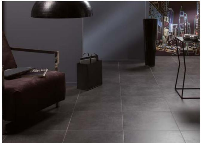
De plus les carreaux doivent bénéficier de la Certification NF UPEC avec l'option "D" obligatoire (caractéristiques dimensionnelles réduites définies dans le cahier 3659 du CSTB) et peuvent être posés à joints décalés et/ou réduits, le décalage maximal autorisé des joints est de 1/3 de la plus grande longueur et la largeur minimale des joints doit être de 3 mm.
