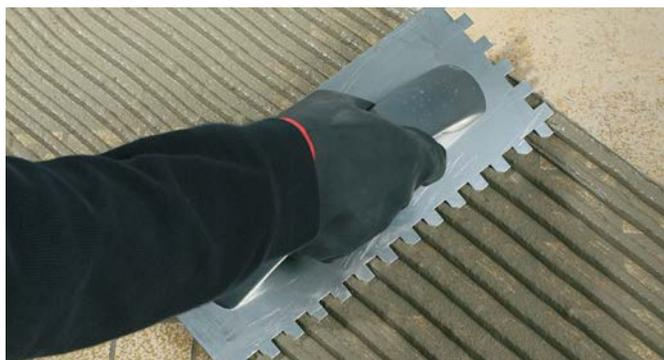
Pour éviter les contraintes mécaniques dans le cas de pose d'un carrelage de même format que celui existant, poser à joints décalés (1/3 environ).
