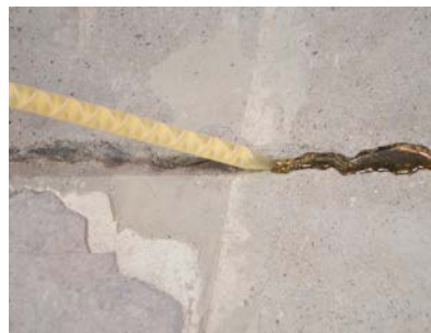
2 : Comblir la fissure
