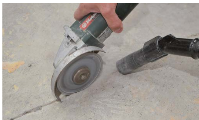
1 : Ouvrir la fissure
