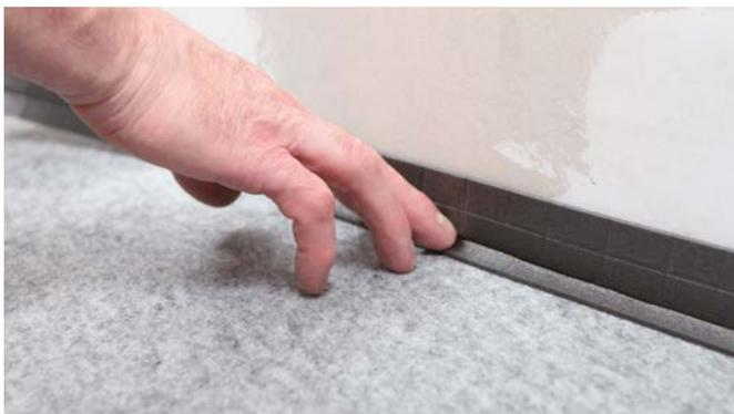
Appliquer la bande de désolidarisation autocollante directement sur la sous-couche, en laissant remonter la partie non-adhésive de la bande.
