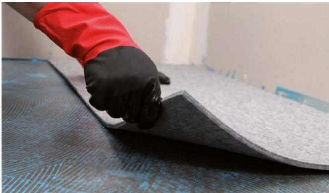
Poser l'isolant acoustique sur le CERMITAK PLUS, face lisse vers le haut, face avec relief en contact avec la colle CERMITAK PLUS. Disposer les plaques selon une pose droite à joints décalés (20 cm). Découpe à l'aide de cutter ou lame crochet. Chaque plaque doit être serrée contre celles déjà en place dans les 2 sens, sans joint en sifflet. Choisir dans la pièce un angle de référence pour débiter la pose.
