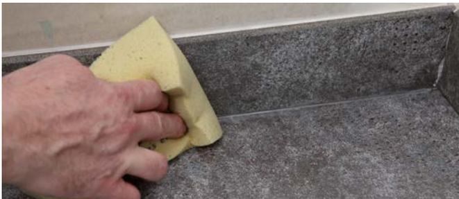
Dans les pièces humides telles que les cuisines, salles de bain et toilettes, parfaire la finition du joint en pied de plinthe avec un mastic souple, classé 25E : CERMISIL HP.
