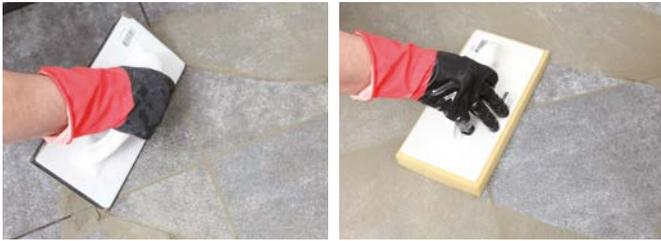
Gâcher 5 kg de CERMIJOINT R PLUS avec 0,8 à 0,9 litres d'eau. Application avec une raclette en caoutchouc en appuyant fortement afin que les joints se remplissent dans toute leur profondeur. Nettoyage avec une éponge moussée légèrement humide (Utiliser le KITAJOINT). Nous conseillons de travailler par gâchée de petites quantités afin de respecter la durée pratique d'utilisation (40 min à 20°C).
