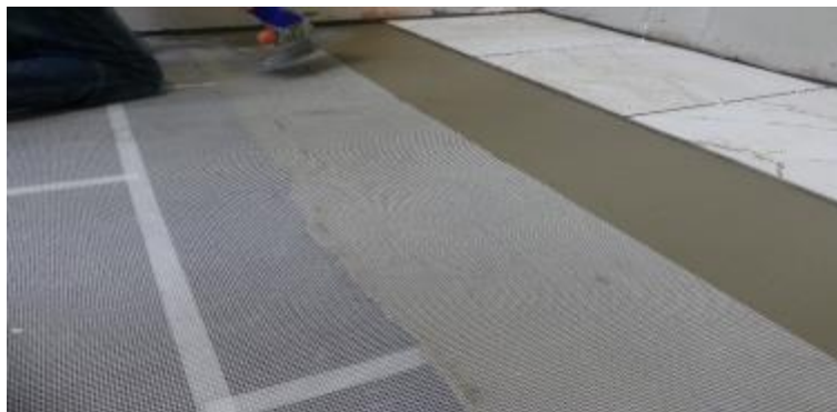
Figure 9 - Mise en œuvre du deuxième lès de treillis WG50 en respectant un recouvrement de 5 cm avec le premier lès
