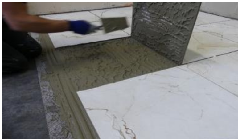
Figure 10 - Vérification optionnelle du transfert à l'avancement de la pose
