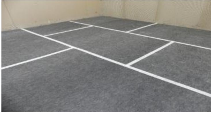
Figure 2 - Mise en œuvre de la sous couche CERMIPHONE XL avec bande de pontage sur support préalablement ragré
