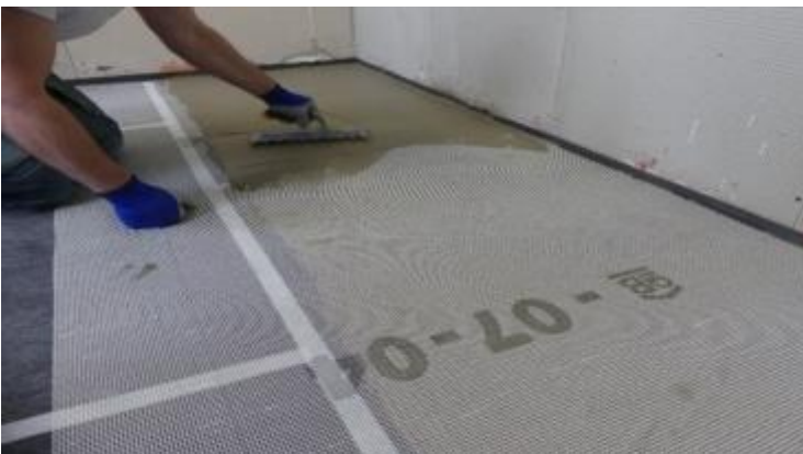
Figure 5 - Mise en place du treillis WG50 dans la couche de CERMIFLOOR Fibré par marouflage à l'aide d'une lisseuse
