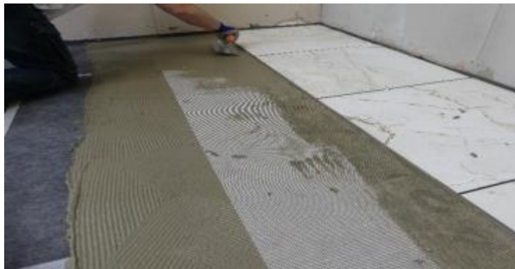
Figure 8 - Appliquer sur la sous couche CERMIPHONE XL le CERMIFLOOR Fibré à l'aide du peigne V4 puis mise en place du treillis WG50 comme en figure 5
