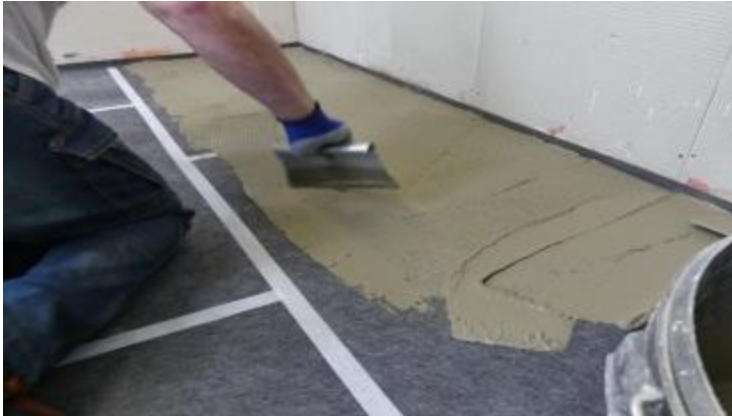
Figure 4 - Application première couche de CERMIFLOOR Fibré avec peigne V4
