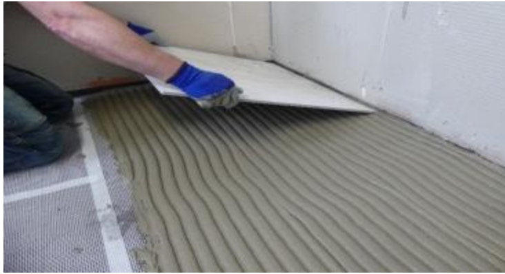
Figure 6 - Mise en œuvre du carrelage dans le CERMIFLOOR Fibré à l'avancement de la pose du treillis WG50 en utilisant le peigne du kit
