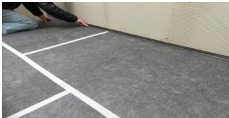
Figure 3 - Mise en place de la bande de désolidarisation périphérique collée sur la sous-couche CERMIPHONE XL
