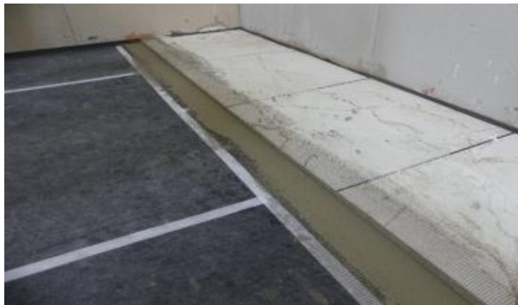
Figure 7 - Relever le treillis WG 50 sur la rangée de carreaux préalablement collés
