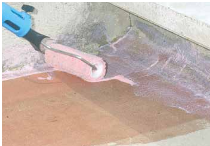
Aanbrengen met rol
