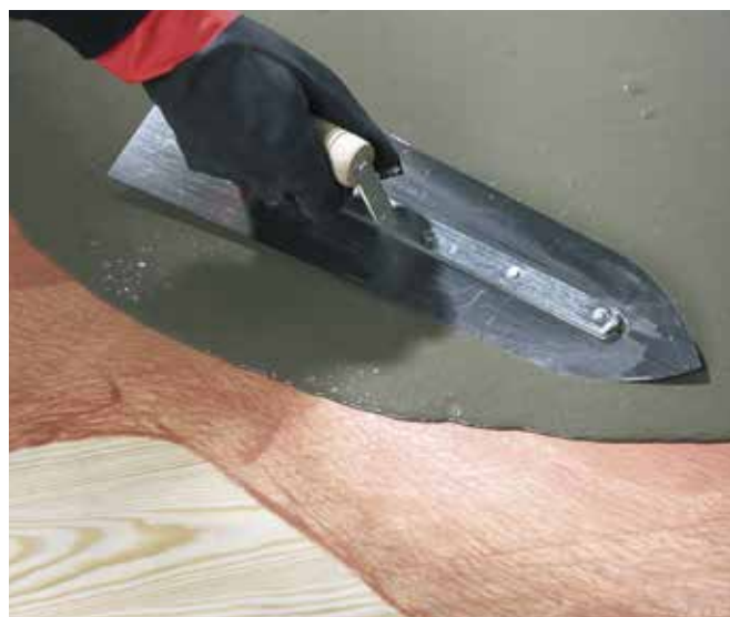
Associé au ragréage fibré RAGRENOV S30 ou RAGREFOR - pose sur bois
