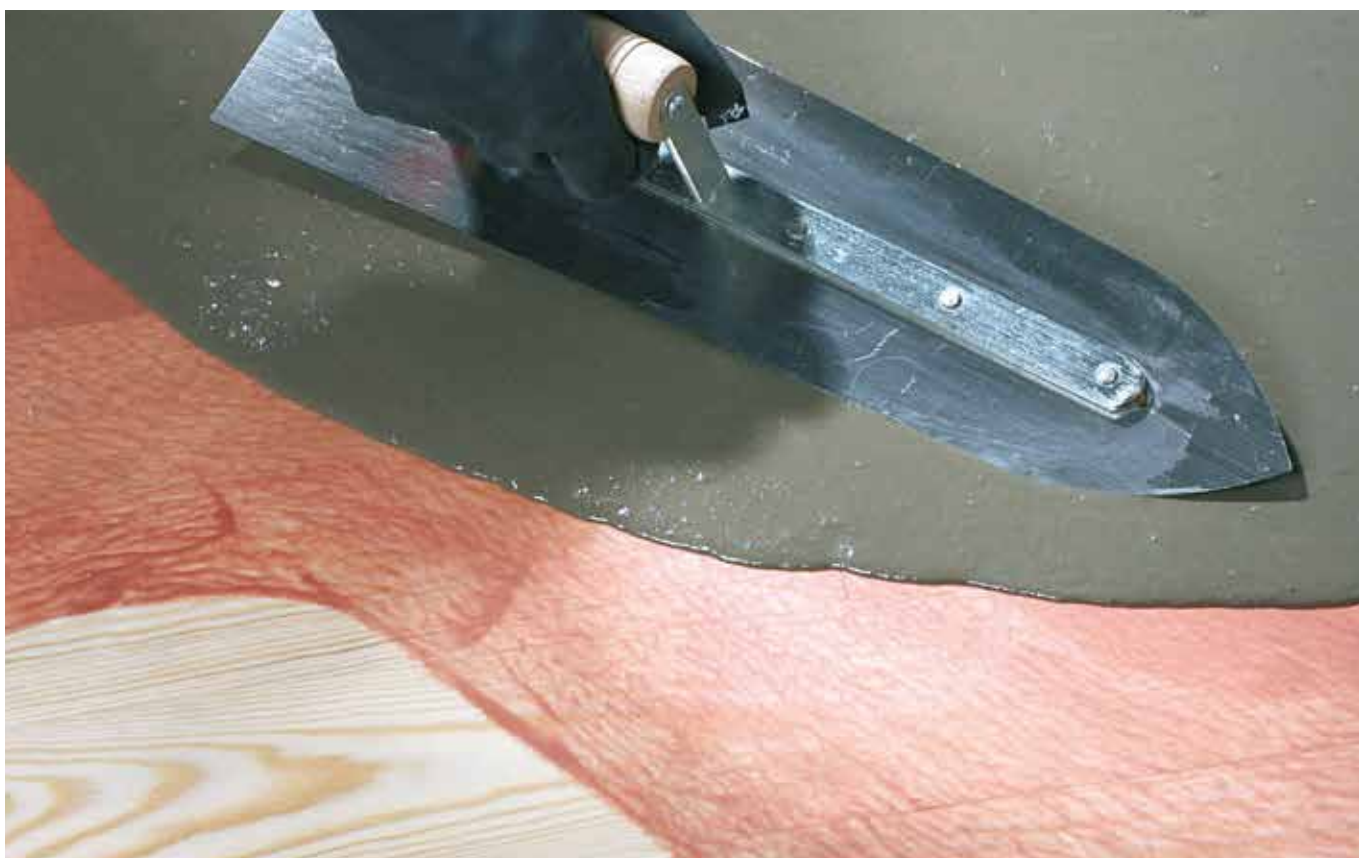
Samen met een vezelversterkte egaline RAGRENOV S30 of RAGREFOR - plaatsing op hout
