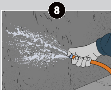
Humidifier le support avant application du produit. Le support sera mat humide, non ruisselant
