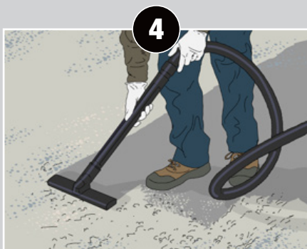
Aspiration soigneuse du support. Toute particule, poussière, partie friable ou non adhérente sera éliminée
