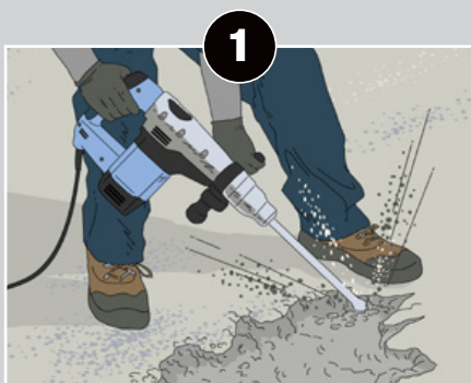
Démolition et reprofilage des parties peu ou pas adhérentes
