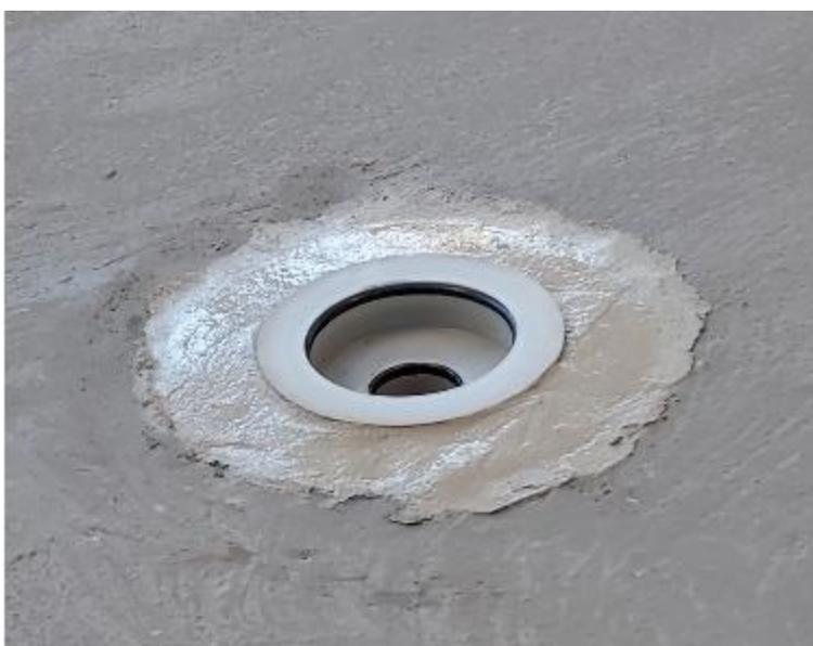
**Photo 1b - Mise en œuvre de l'embase du siphon acoustique**
