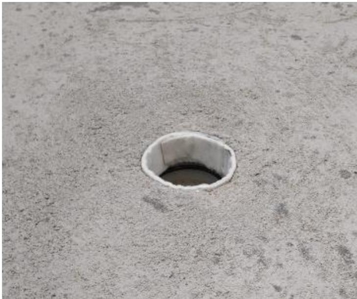
**Photo 1d – Mise en œuvre de la chape et arasage de la sous couche**
