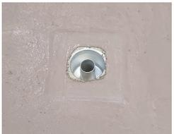
Photo 10 : SEL CERMIPROOF ST ou CERMICRYL TRAME en partie courante.
