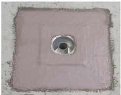
Photo 9 : Traitement du raccord platine et chape, marouflage de la bande d'armature.
