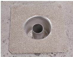
Photo 8 : Primairisation et sablage de la platine du siphon
