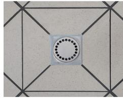
Photo 11 : Ouvrage carrelé et grille de siphon posée
