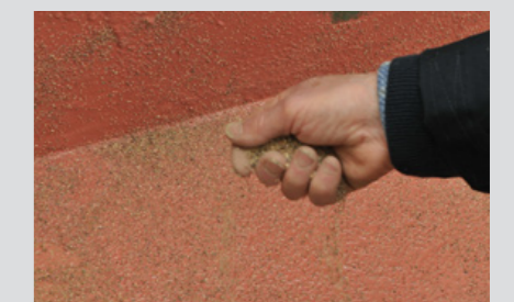
6 - Sablage sur la deuxième couche avant séchage
